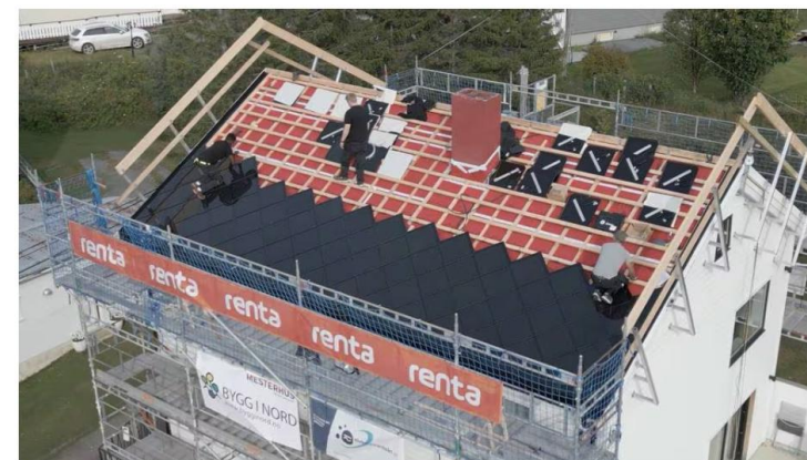
Et gjenreisningshus i Senja kommune får solceller integrert i taket. Forskere ved UiT skal observere taket de tre neste årene.
