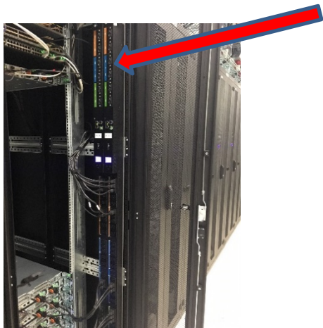
Figur 3 Plassering av PDU i rack
