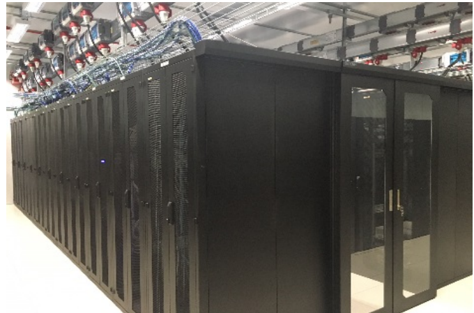
Figur 5 Eksempel på en kubekjøleløsning
