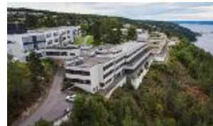
Sunnaas sykehus HF Byggetrinn 3
