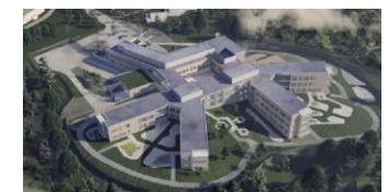
Oslo universitetssykehus HF Ny sikkerhetspsykiatri
