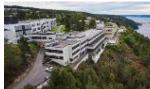
Sunnaas sykehus HF Byggetrinn 3
