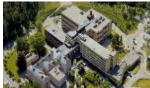
Sykehuset Telemark HF Utbygging somatikk Skien
