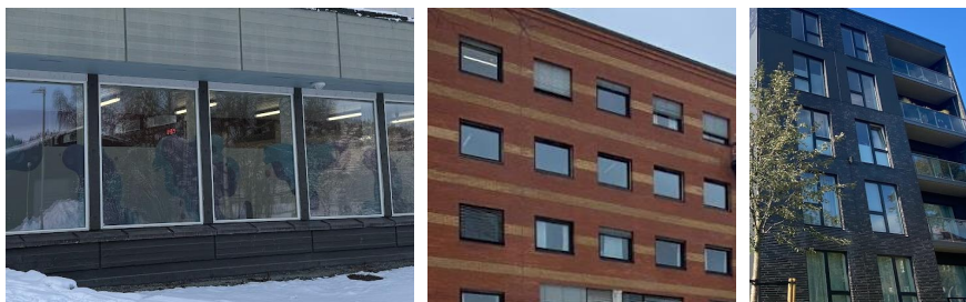
Vinduer med isolerglass - Fra 2005 - 2017
