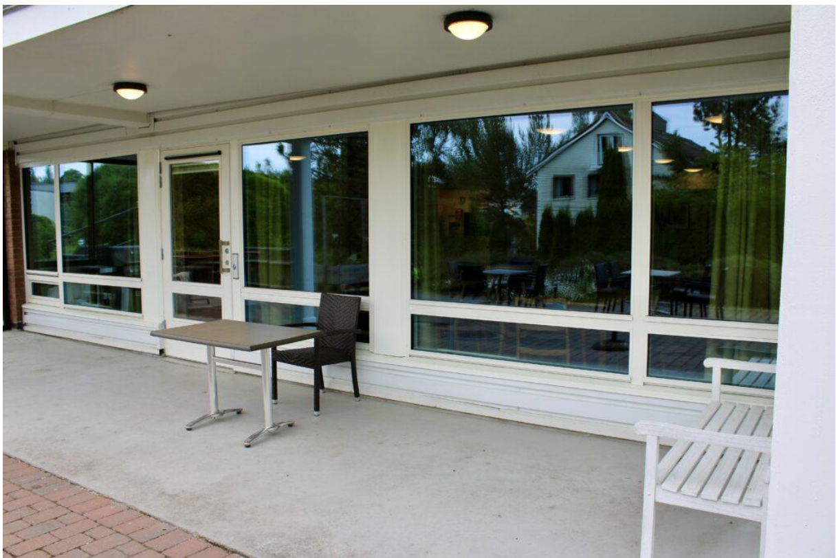
Etter oppgradering fasade grunnplan bakside
