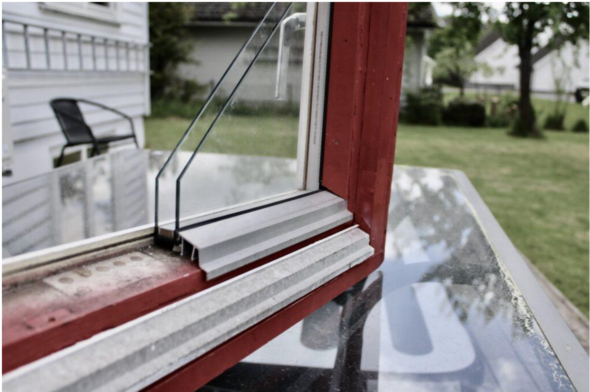
Snitt av et vindu før oppgraderingen (Illustrasjonsbilde, Z-Clix)
