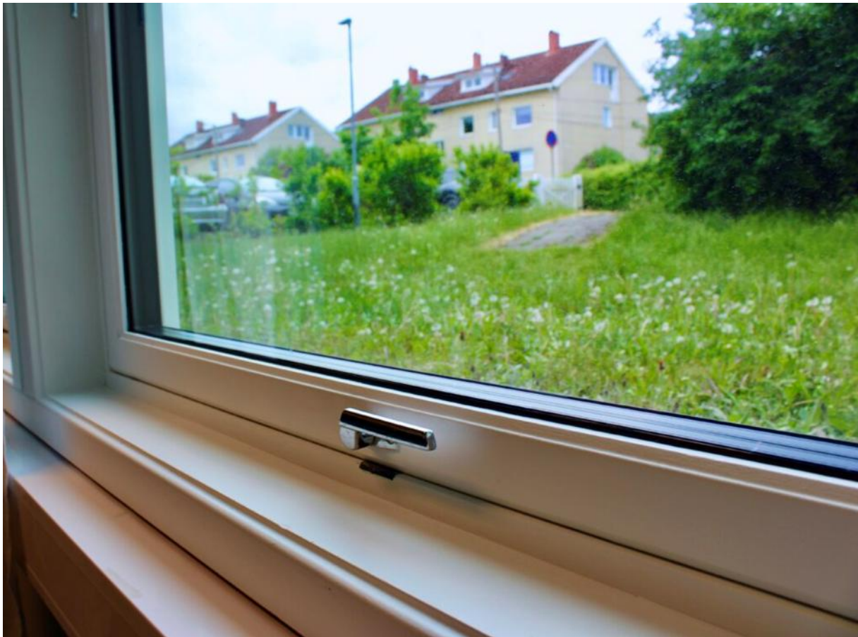
Karmer/rammer ble malt på innsiden og så slik ut etter arbeidene var utført.
