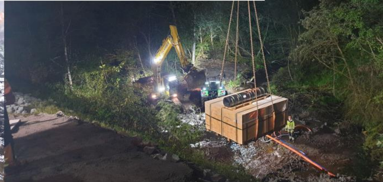
Veien ble stengt i 30 min om natten for å heise kassen med 7 tonn strømpe på plass.
