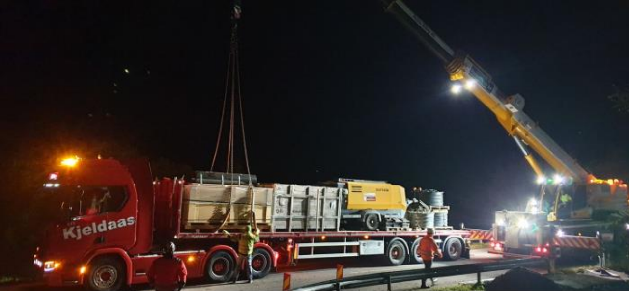
Veien ble stengt i 30 min om natten for å heise kassen med 7 tonn strømpe på plass.
