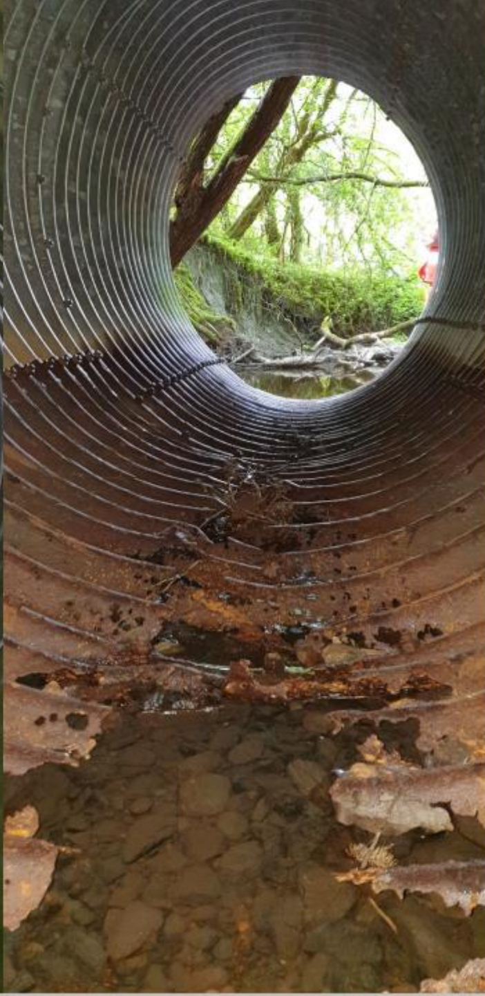
Fosen - 2021: Bunnen i galvanisert stikkrenne DN2000 har fått nytt liv med glassfiberarmert strømppe med strukturell styrke
