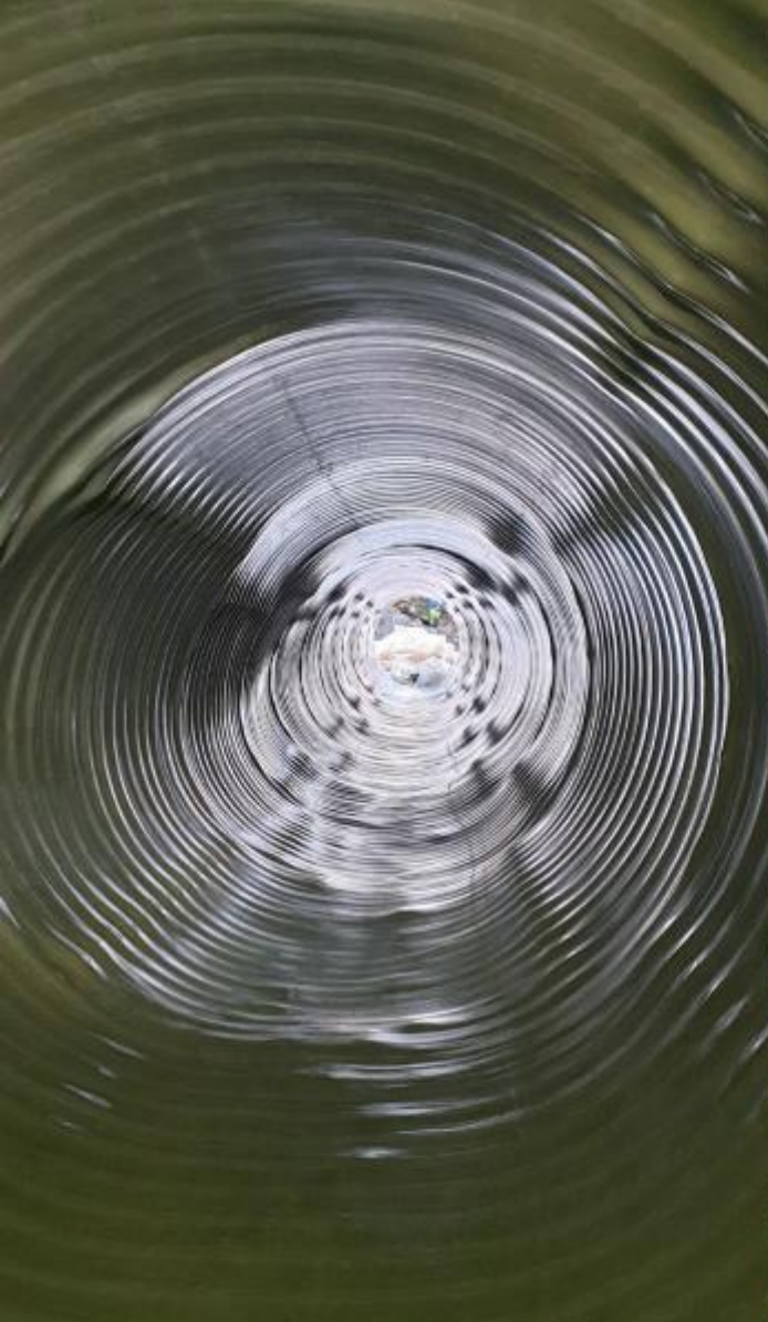
Fosen - 2021: Bunnen i galvanisert stikkrenne DN2000 har fått nytt liv med glassfiberarmert strømppe med strukturell styrke
