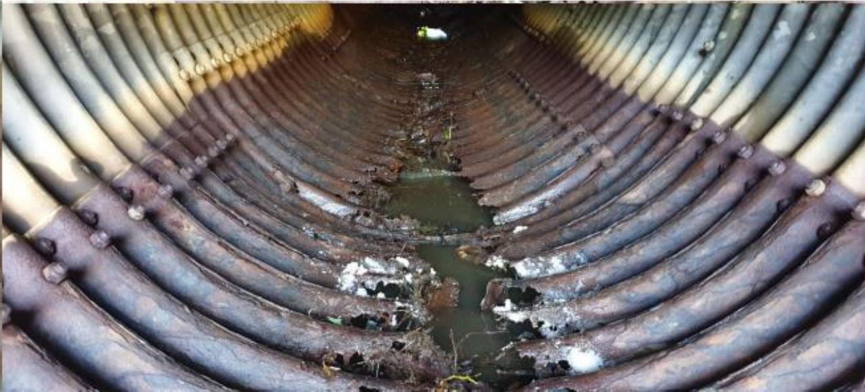
Ikke ukjent skadebilde av korrugert stålrør
