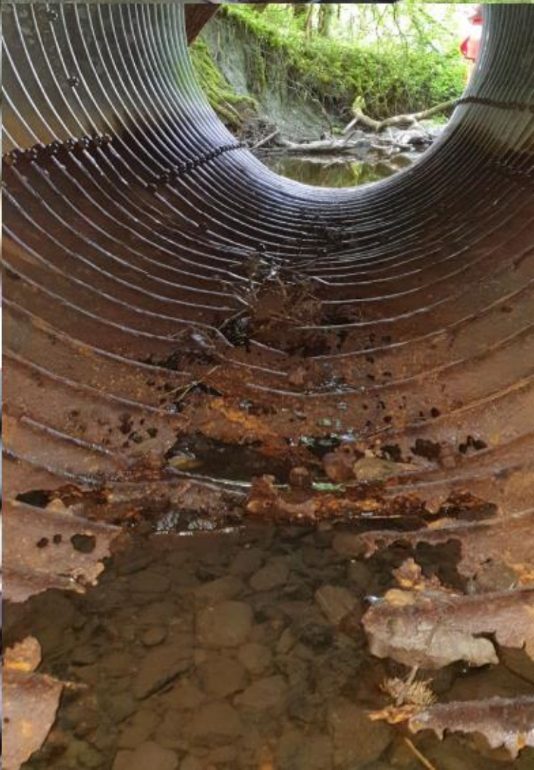
Ikke ukjent skadebilde av korrugert stålrør
