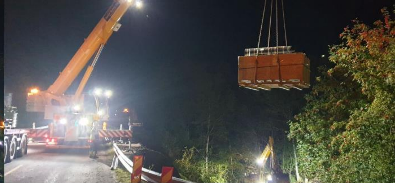
Veien ble stengt i 30 min om natten for å heise kassen med 7 tonn strømpe på plass.
