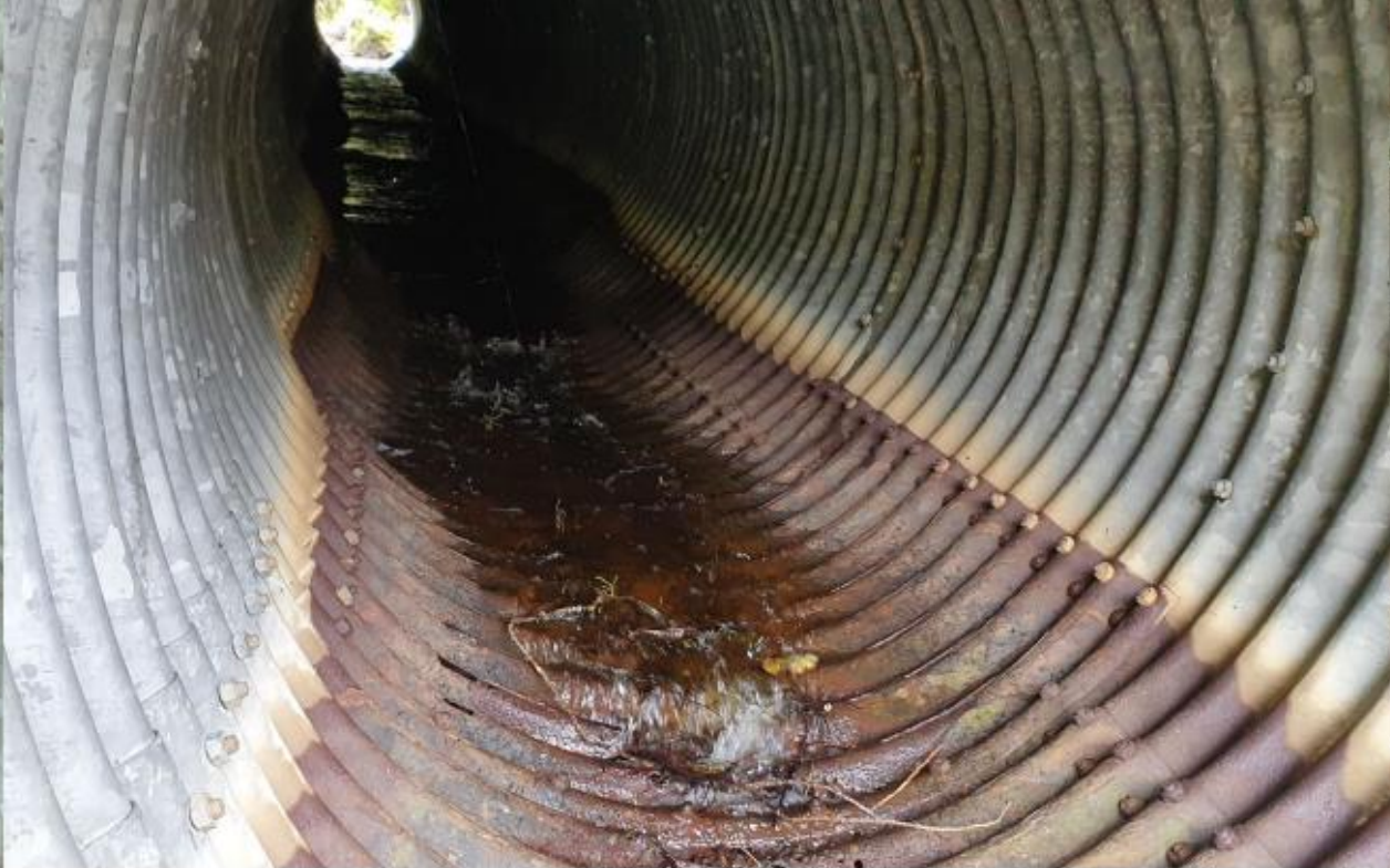
Ikke ukjent skadebilde av korrugert stålrør
