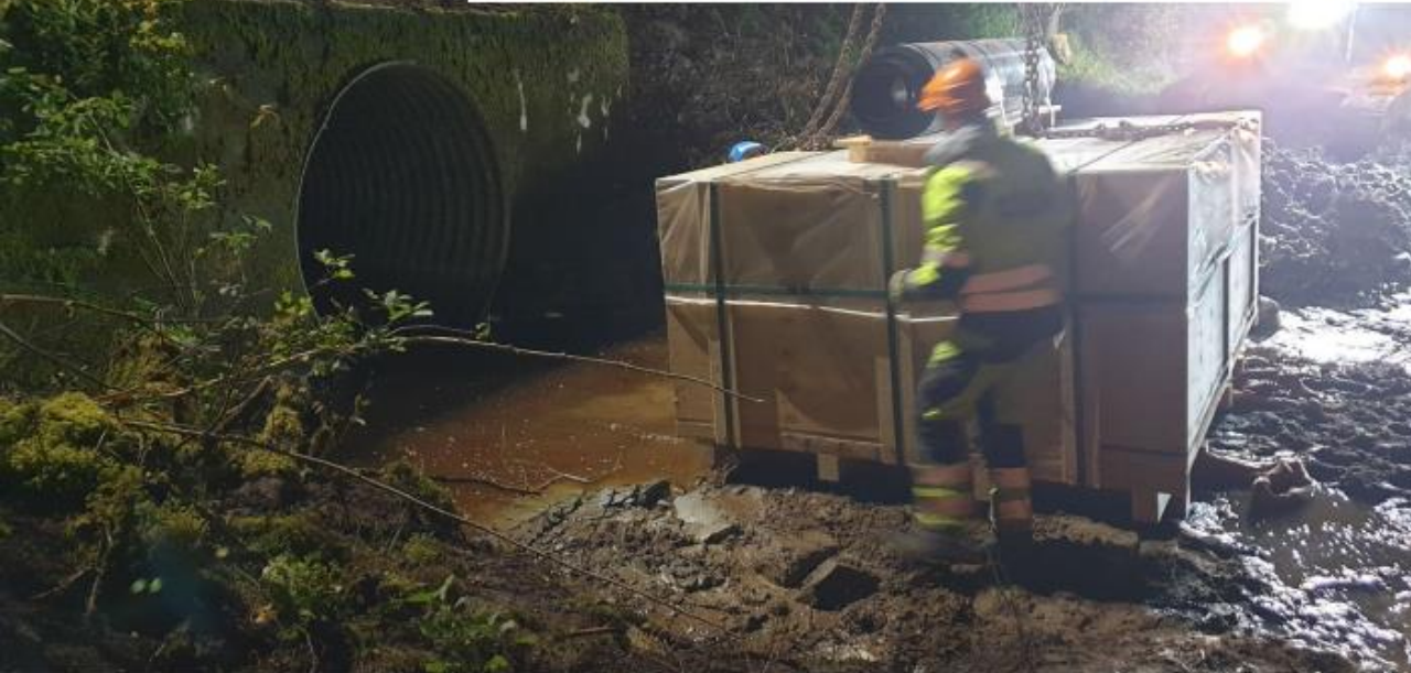
Veien ble stengt i 30 min om natten for å heise kassen med 7 tonn strømpe på plass.
