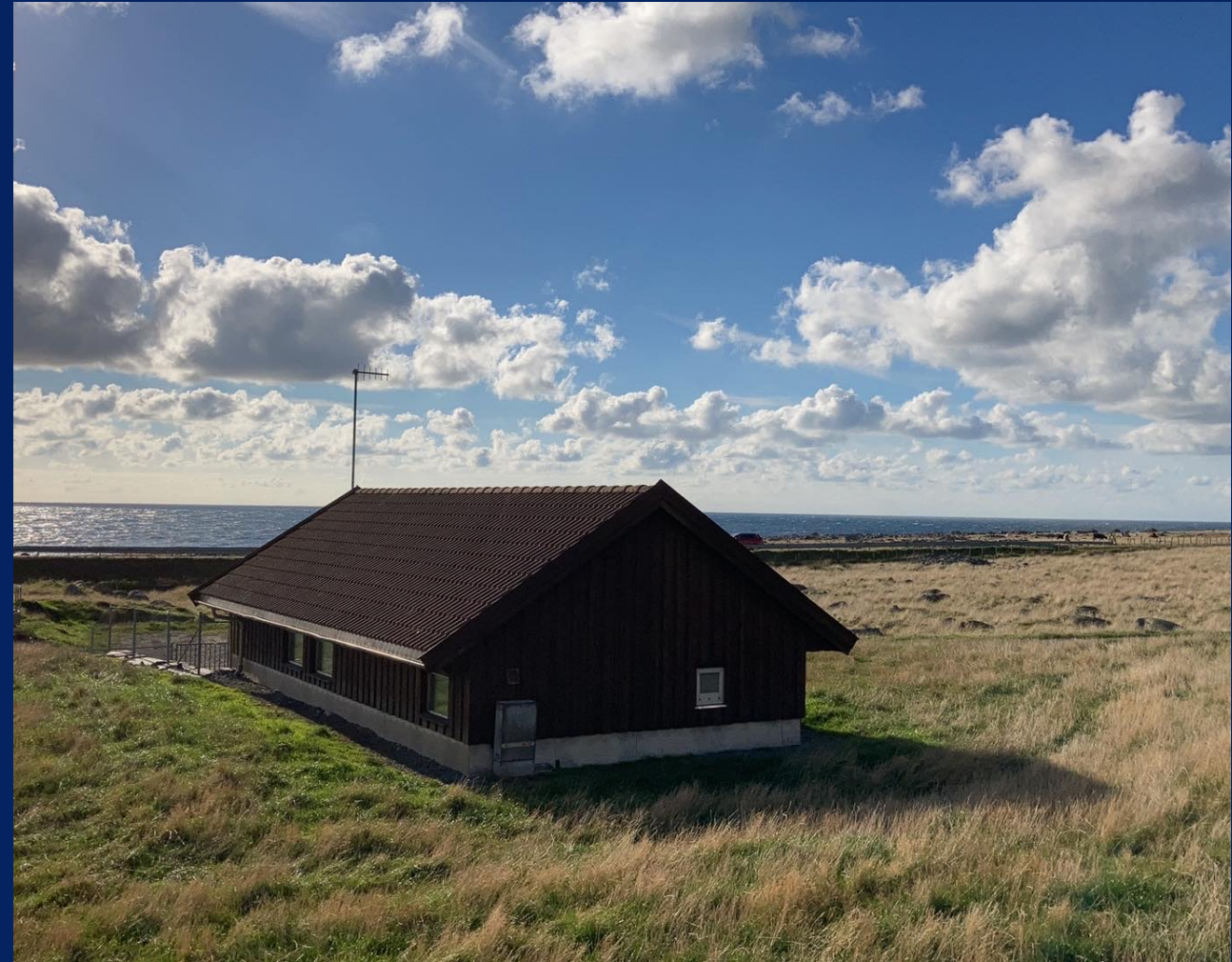
Vigrestad (primær-)renseanlegg, Hårr
