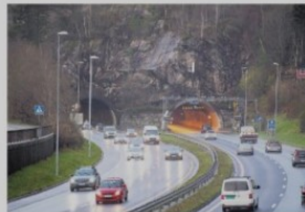
E39: Også Glaskartunnelen i Åsane skal oppgraderes. Byggestart skulle egentlig vært høsten 2022.
