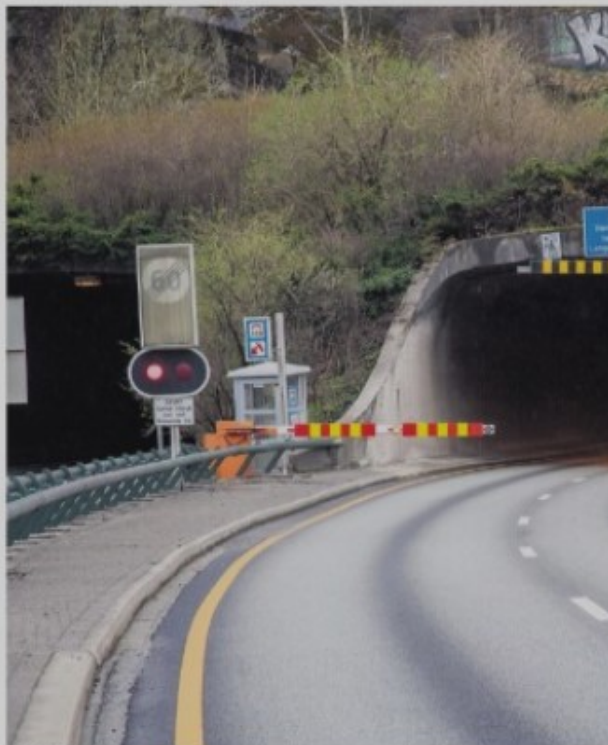
RIKSVEI 555: Damsgårdstunnelen var egentlig del av et enda større prosjekt, men prisen som kom inn var langt høyere enn hva Vegvesenet kunne betale.
