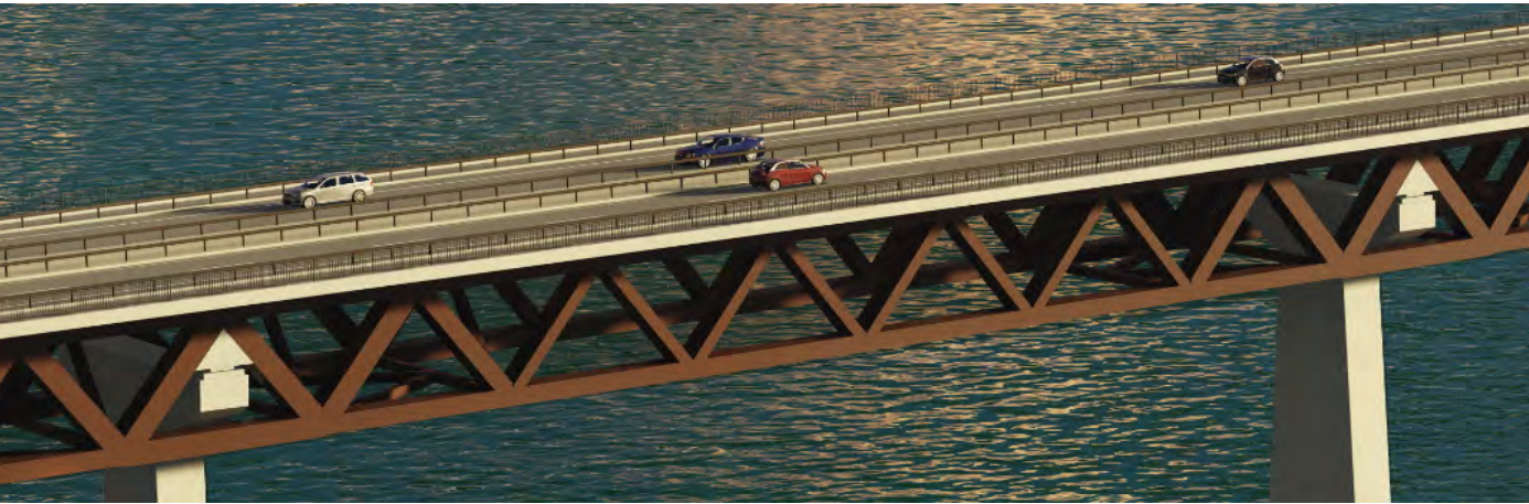
Figur 14 Bruoverbygningen i ett typisk sidespenn
