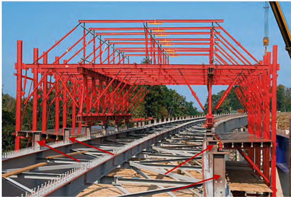
Figur 45 Eksempel på framkjøringsvogn for samvirkebruer. Oppleggsstøttene er markert med røde piler (© PERI)
