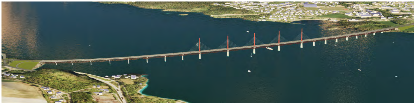
Figur 1 Oversiktsbilde av trebrua, sett fra sørvest
