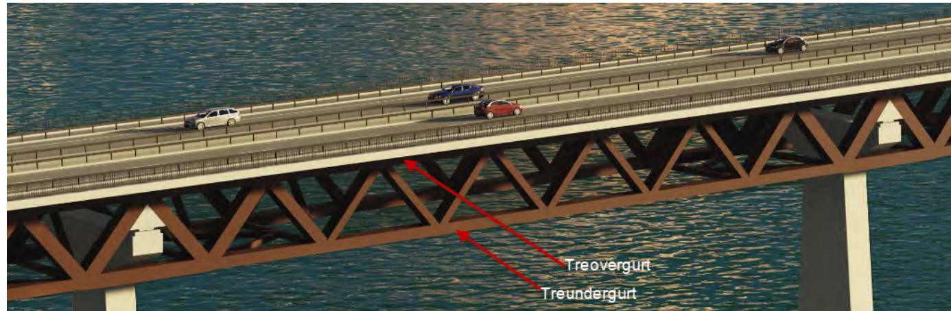
Figur 17 Romlig trefagverk i typisk sidespenn.
