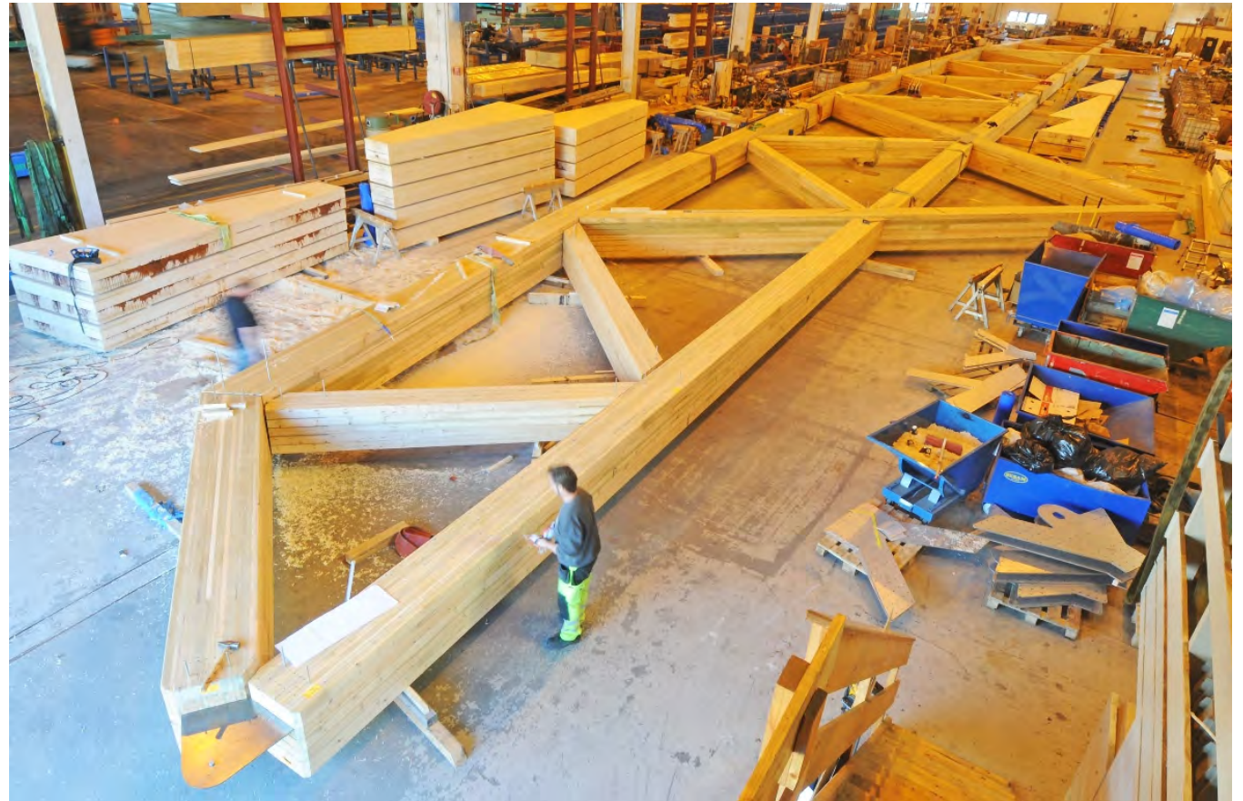
Figur 72 Ett av to fagverk lagt opp i fabrikk til Moelven limtre
