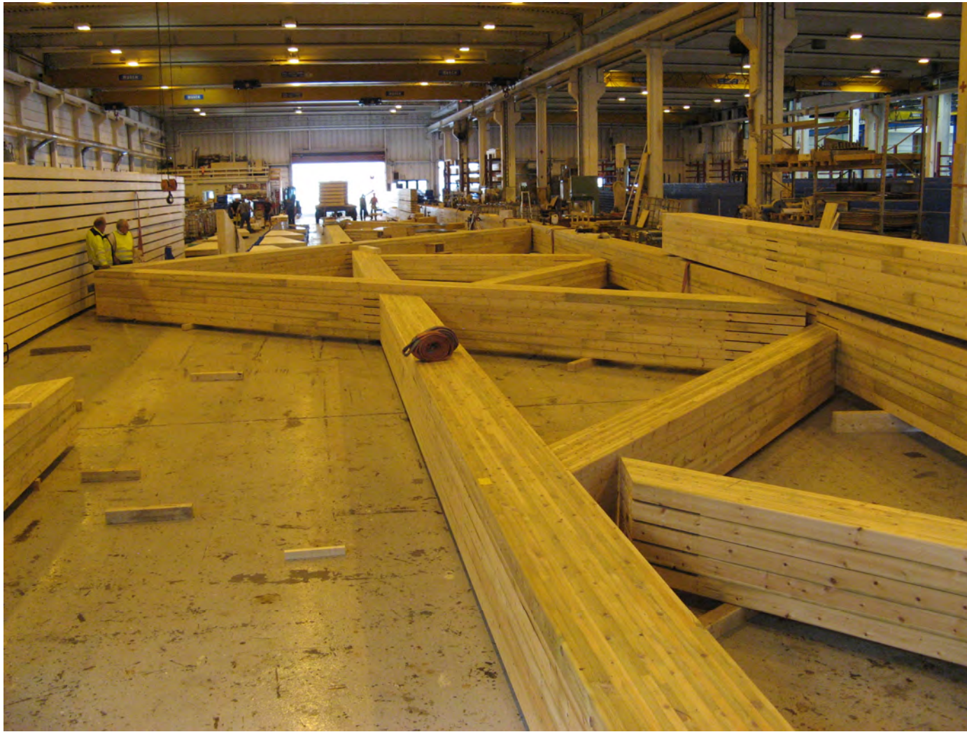
Figur 73 Ett av to fagverk lagt opp i fabrikken til Moelven limtre
