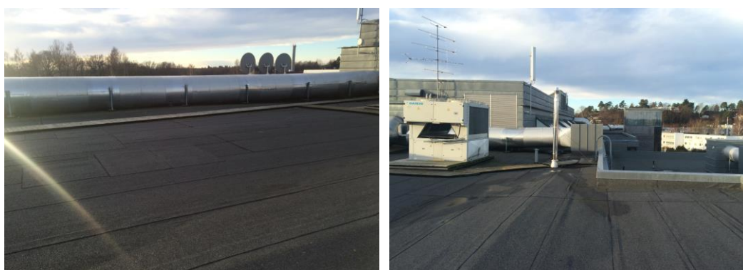
Figur 38 – Sandefjord VGS. De aktuelle takflater er delvis oppdelt og hindret av ventilasjonskanaler, rør, anlegg og andre bygningsdeler. (Foto: Lunde, Sweco).
