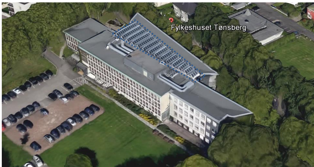
Figur 84 – Markering av glassfelt som er aktuelle for utnyttelse av bygningsintegrerte solceller i nytt glassfelt (sørøstvendte flater). Solcellene legges med avstand som balanserer dagslys, solstrømproduksjon og solskjerming.
