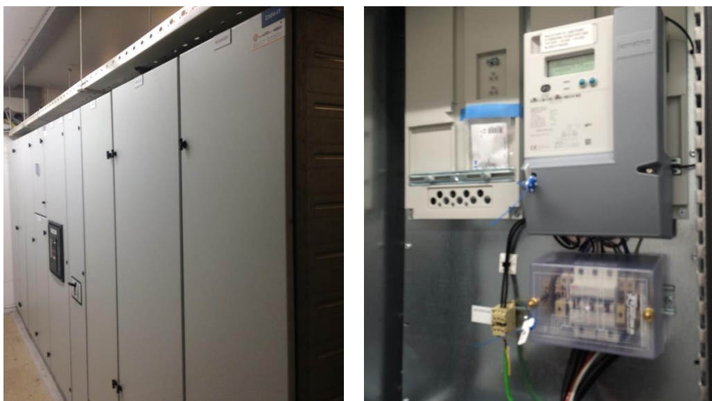
Figur 12 – Venstre: Hovedtavle/hovedfordeling for innmating av solstrøm. Det opprettes egen kurs for dette, med tilhørende nettanalysator. Høyre: Hovedmåler for EL hvis timesverdier for forbruk er lagt til grunn for lønnsomhetsberegningene. (Foto: Lunde, Sweco).
