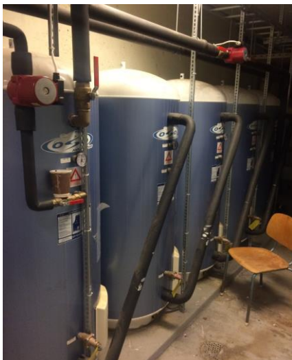
Figur 60 – Venstre: Varmtvannsberedere i Greveskogen idrettshall aktuelle for forvarming og oppvarming av varmt tappevann til dusjing m.m. Høyre: Idrettshallen sett fra øst. (Foto: Lunde, Sweco).
