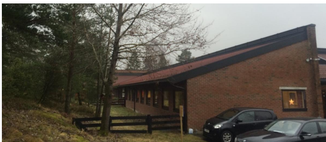
Figur 5 – Skrå takflater delvis skjermet av trær. Skyggevirkninger på produksjon av solstrøm eller solvarme vil her være betydelige.
