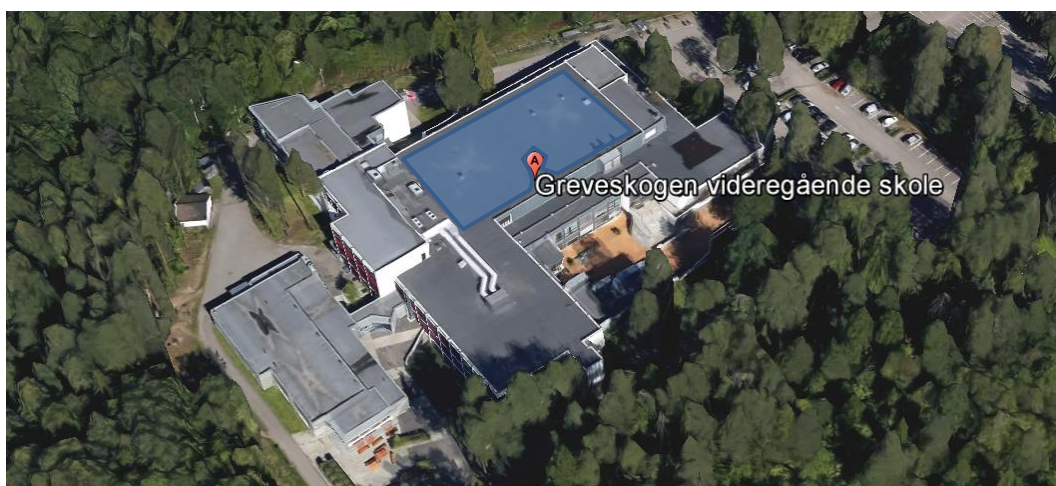
Figur 57 - Markering av de aktuelle takflater på Greveskogen VGS for solenergitiltak. Midtre del av taket for skolen er velegnet for øst/vest-orientert solcelleanlegg, som vil forsyne skolen med solstrøm. (Bilde: Google Earth)
