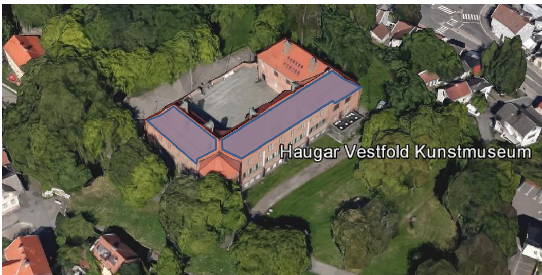
Figur 52 - Markering av de aktuelle takflater på Haugar kunstmuseum for solcelleanlegg. Det kan integreres ferdig solcelleløsninger i takstein/takflaten for å ivareta arkitektoniske hensyn for disse flatene, men bruk av ordinære solceller/solfangere vurderes som lite aktuelt. (Bilde: Google Earth)
