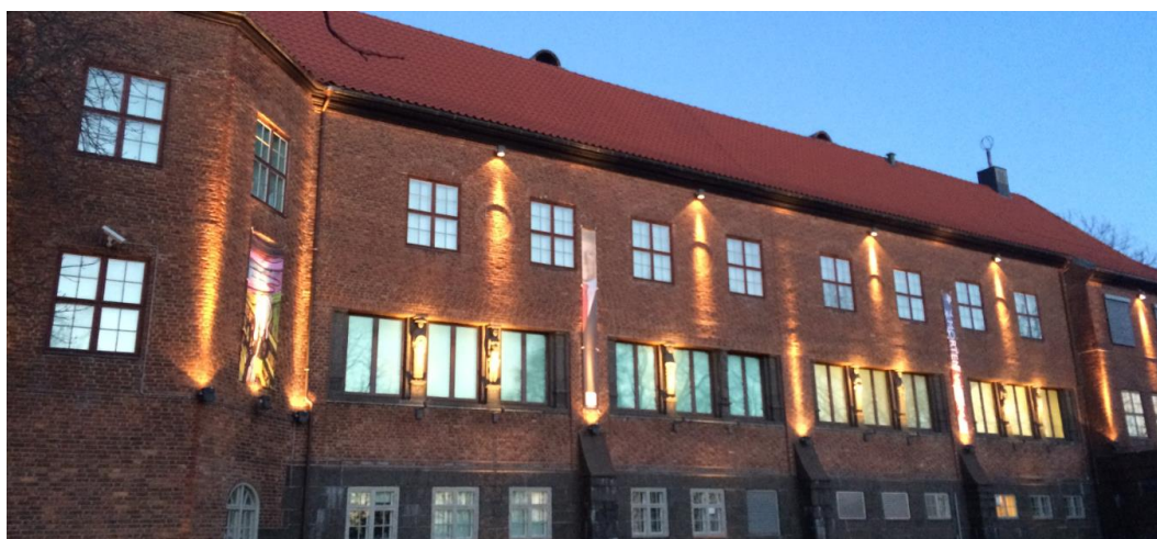
Figur 53 – Haugar Kunstmuseum. Skrå takflate mot sørvest og sørøst er aktuelt for byggningsintegreerte solceller for å ivareta arkitektoniske hensyn. (Foto: Lunde, Sweco).
