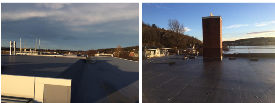
Figur 25 – Venstre: Tilgjengelige takflater på midtre og østre takdel på Kompetansebyggeren «Korten», retning nord. Høyre: flatt tak på søre takdel, retning sør. Interne bygningsdeler fører til skyggeeffekter på takflaten, som gjør at østre og nordre takdel vurderes som mest aktuelle. (Foto: Lunde, Sweco)
