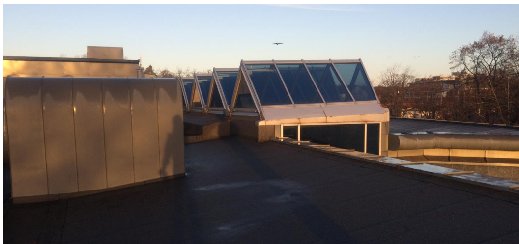
Figur 85 – Glasstak/atrium på Fylkeshuset. Nye glassfelt med integrerte solceller i glasset som aktuell løsning i midten av bildet. Flate takflater i for- og bakgrunn. (Foto: Lunde, Sweco).
