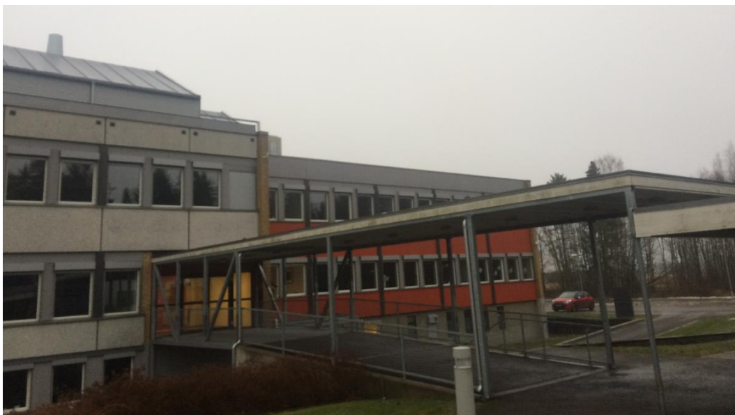
Figur 31 – Sørenden av bygg B, Holmestrand VGS. Flat takflate på enden (høyre) vurderes som mest egnet takflate for solcelleanlegg. (Foto: Lunde, Sweco).
