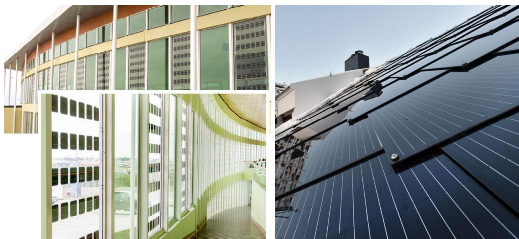
Figur 5 – Venstre: Solceller integrert i vinduer. Høyre: Solceller som takstein. [6]
