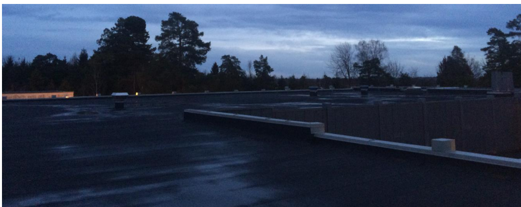
Figur 59 – Tilgjengelig flate takflater på Greveskogen VGS (hovedbygget). (Foto: Lunde, Sweco).
