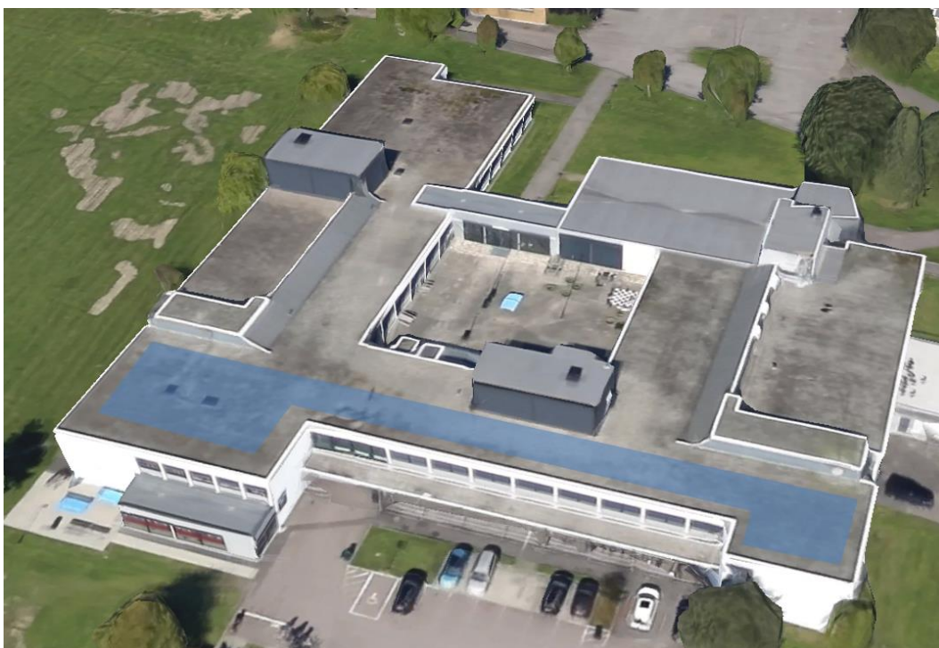
Figur 76 - Markering av de aktuelle takflater på Nøtterøy VGS for solcelleanlegg. (Bilde: Google Earth)
