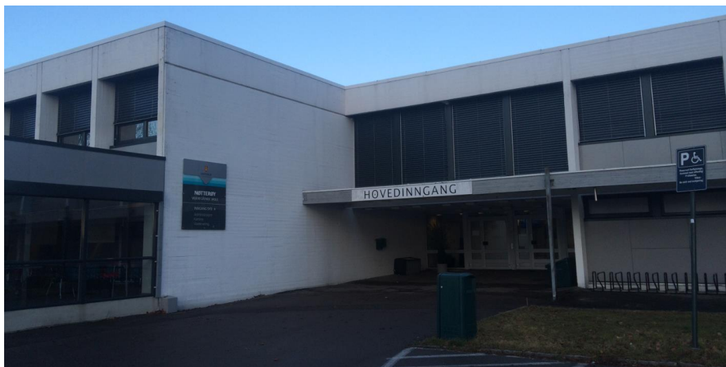
Figur 77 – Nøtterøy VGS. De aktuelle takflater er delvis oppdelt og hindret av ventilasjonskanaler, rør, anlegg og andre bygningsdeler. (Foto: Lunde, Sweco).
