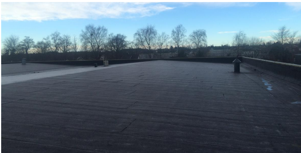
Figur 42 – store tilgjengelig flate takflater for solcelleanlegg på museumslager i Hinderveien 10. (Foto: Lunde, Sweco).
