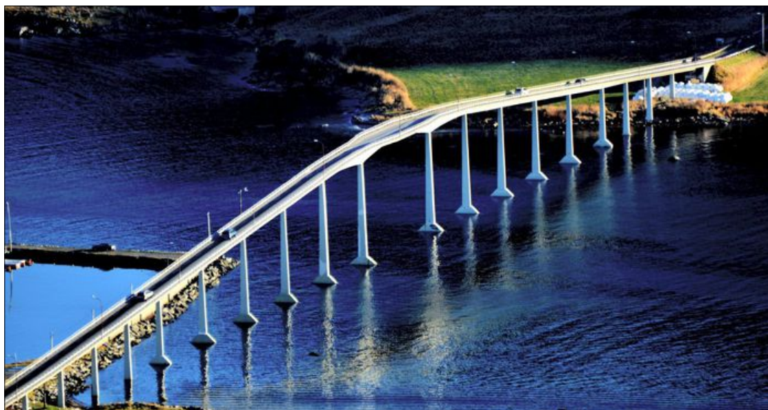
FOR FALL: Nerlandsøybrua mellom Bergsøy og Nerlandsøya i Herøy kommune skal skiftes ut med en ny. Det kan bli det første prosjektet hvor nyutviklede metoder brukes. FOTO: KNUT ARNE AARSET
