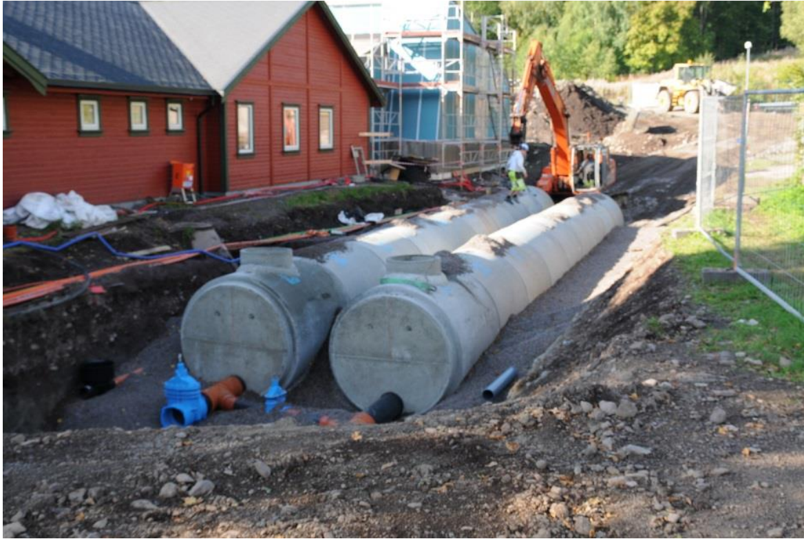
2 stk. magasiner D= 1,60m L=36m Bilde viser halve lengden (18m)
