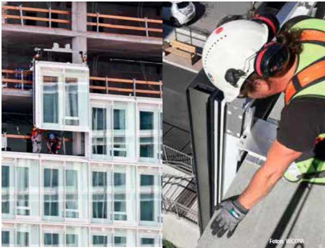
Installasjon ved bruk av kran
