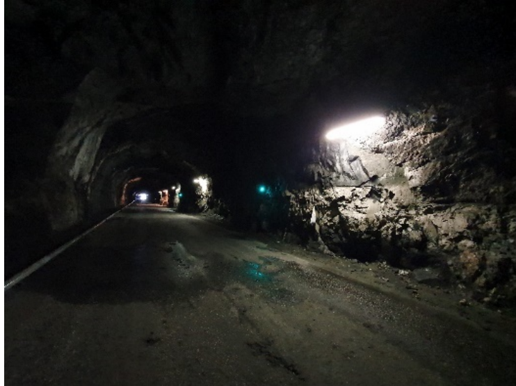
Testområdet i Runehamartunnelen
